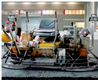
Maszyna do wygładzania betonu
